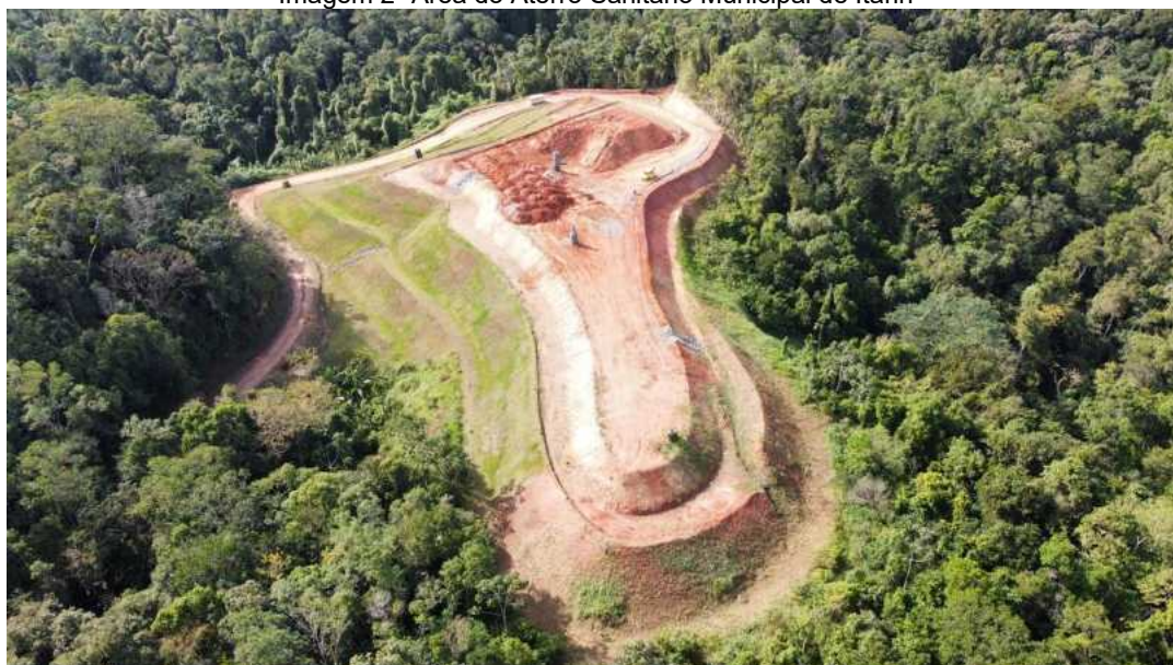
Imagem 2- Área do Aterro Sanitário Municipal de Itariri
