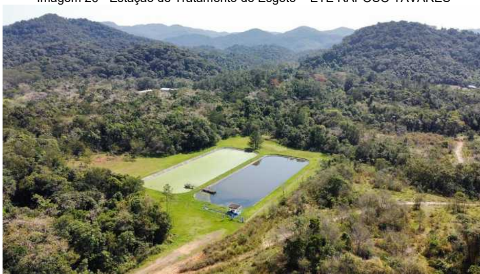
Imagem 26 - Estação de Tratamento de Esgoto – ETE RAPOSO TAVARES
