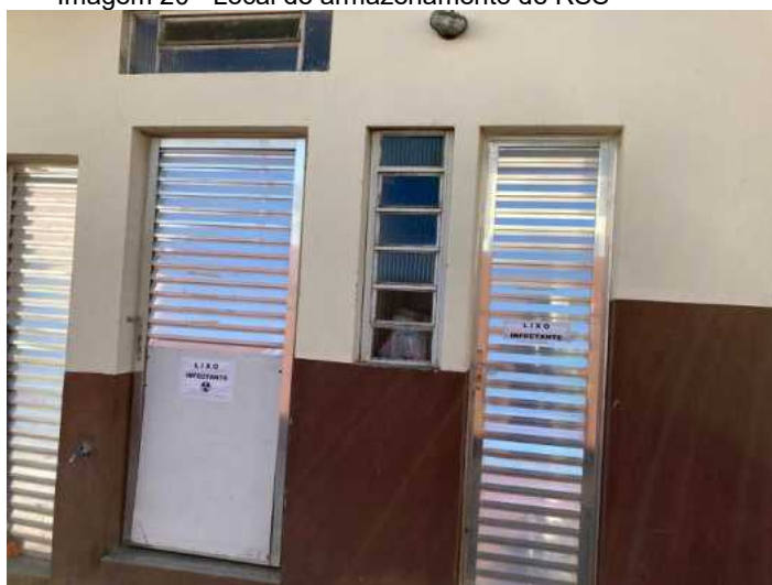
Imagem 20 - Local de armazenamento de RSS
