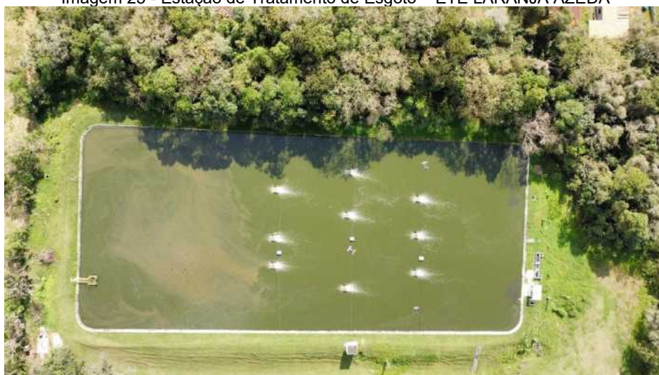
Imagem 25 - Estação de Tratamento de Esgoto – ETE LARANJA AZEDA
